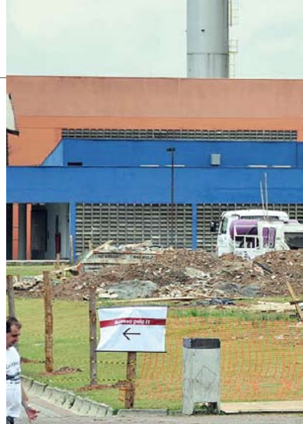
Betoneiras em operação na área contaminada
