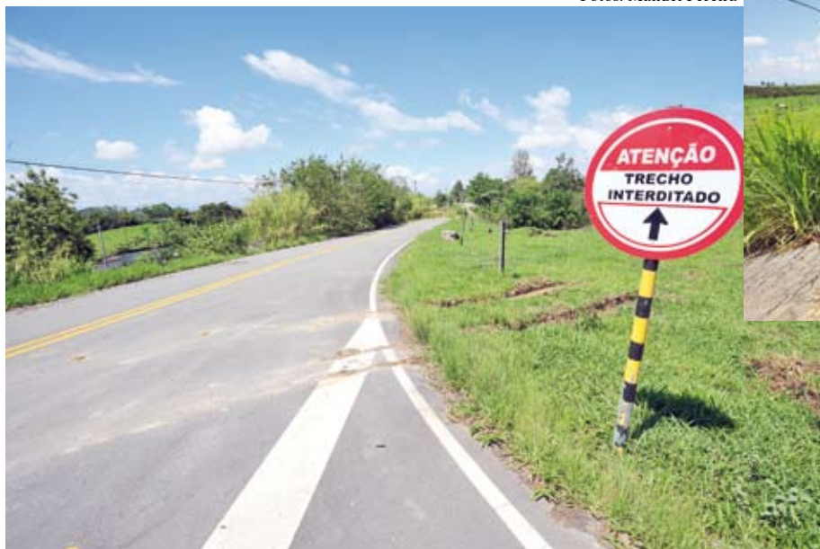
Em 2010, desmoroamento interrompeu principal acesso ao Campus I
