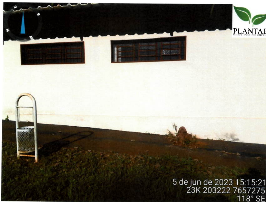
Foto 32. Demonstram áreas onde foram realizados cortes devido ao estado fitossanitário, risco de queda e danos as estruturas patrimoniais.
