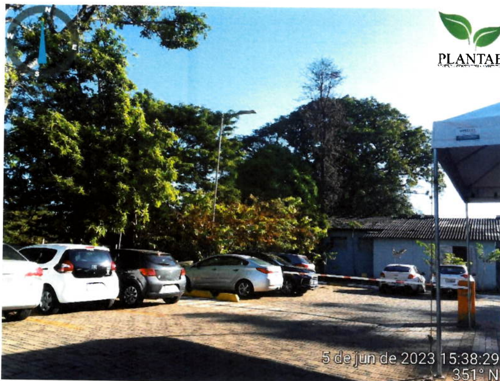
Foto 28. Demonstram áreas verdes e áreas permeáveis do campus, em locais de intervenção, com presença de árvore morta com alto risco de queda e geração de acidentes, em monitoramento técnico e em processo de licenciamento de corte.
