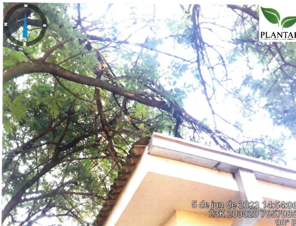
Foto 31. Demonstram locais de intervenção para manejo florestal de indivíduo em estado fitossanitário ruim e com alto risco de queda de galhos pendentes para os telhados, gerando prejuízos e danos ao patrimônio do campus.
