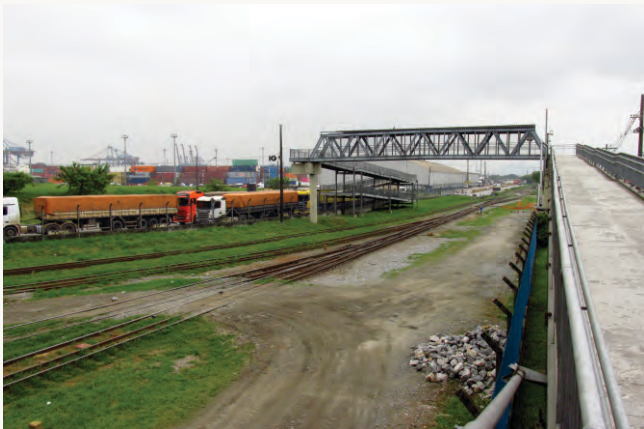
Vista geral da linha férrea (Uso Institucional e Equipamento Urbano).
