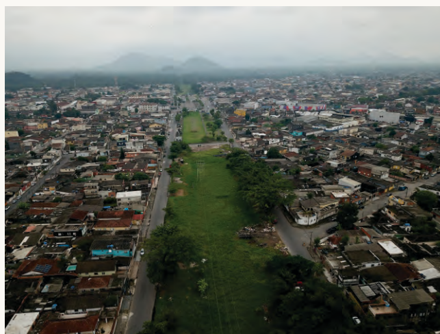
Vista geral de área urbana e de campo antrópico com árvores na faixa de servidão de LT, no bairro Vicente de Carvalho, Guarujá.
